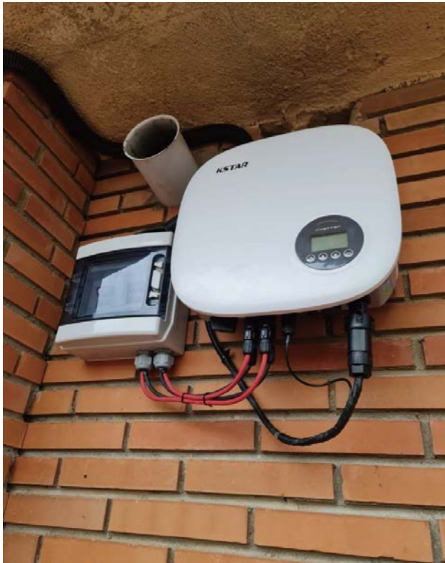
08 Wohn-Solarenergieprojekt in Brasilien
